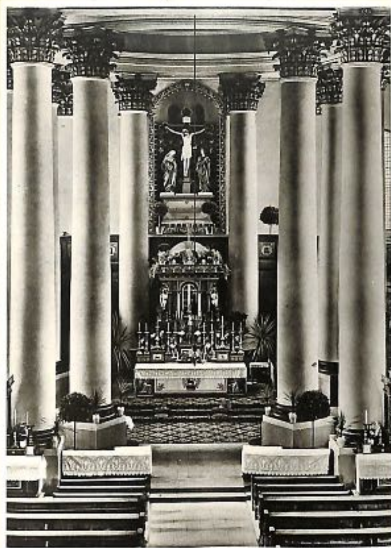
vor der Renovierung
