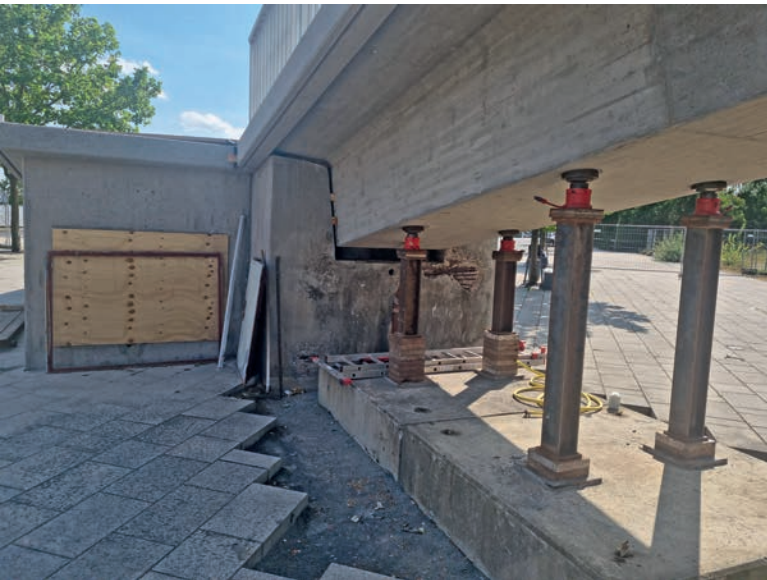
Hub des Brückenastes Falaiser Platz / ZOB für Lagertausch Foto: Stadtbauamt
