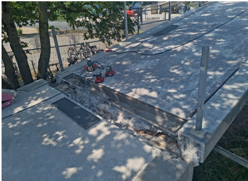
Ausgebaute Übergangskonstruktion am Ast „Triamare“ Foto: Stadtbauamt
