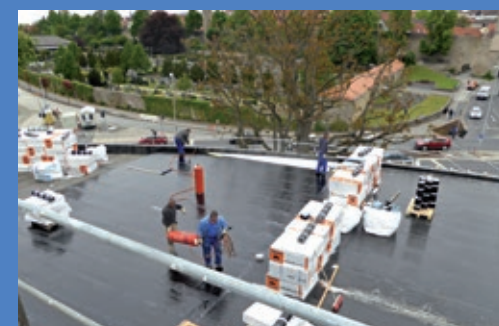
Neubau Stadthalle Baustandsbericht
