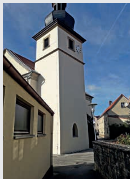
Außenfassade nach Sanierung Foto: Stadtbauamt Bad Neustadt a. d. Saale
