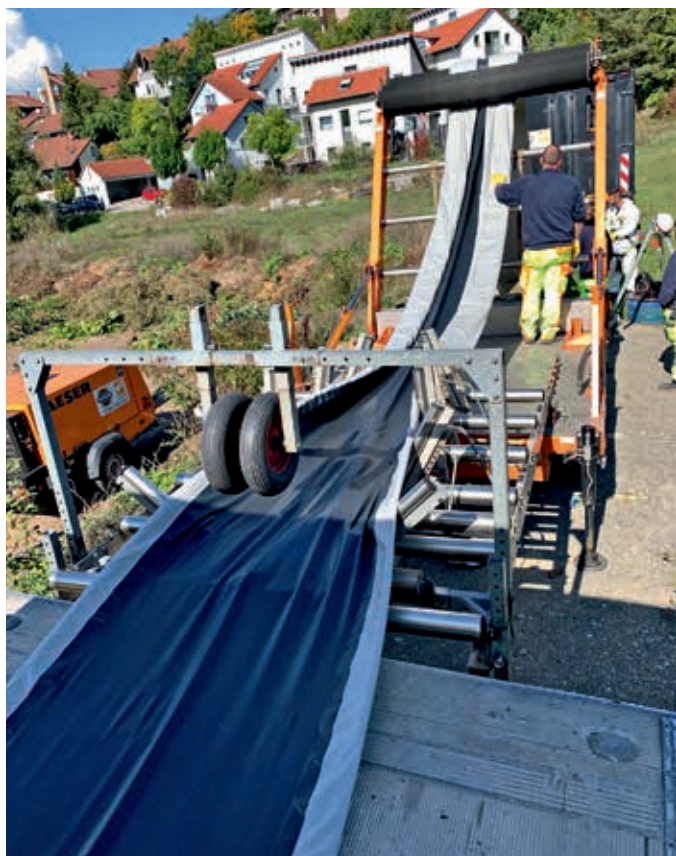
Einzug Inlinerschlauch über Seilwinden in ein Schachtbauwerk Foto: Abwasserverband
