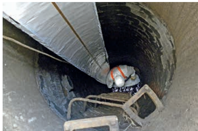
Einzug Inlinerschlauch über Schacht in Rohrleitung Foto: Swietelsky-Faber
