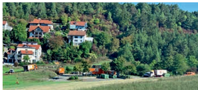
Baustelleneinrichtung Bereich Grüngutsammelplatz Foto: Abwasserverband
