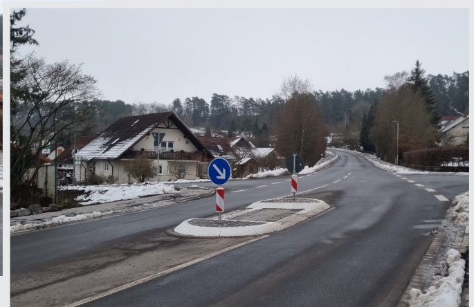
Querungshilfe Quelle: Stadtbauamt
