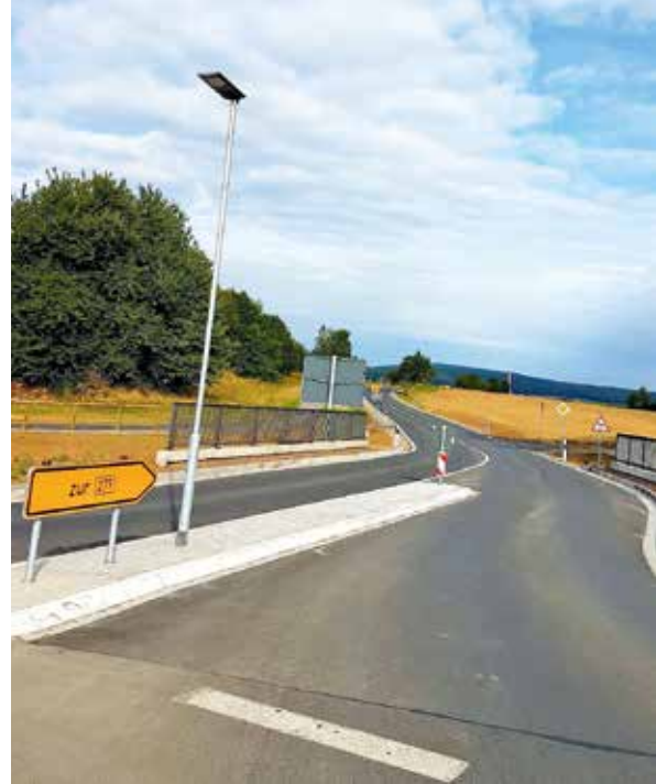
Erneuerte Asphaltdecke Richtung B 279
