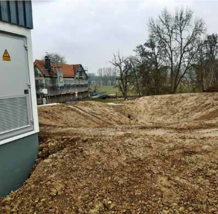
Foto: Regenrückhaltebecken
