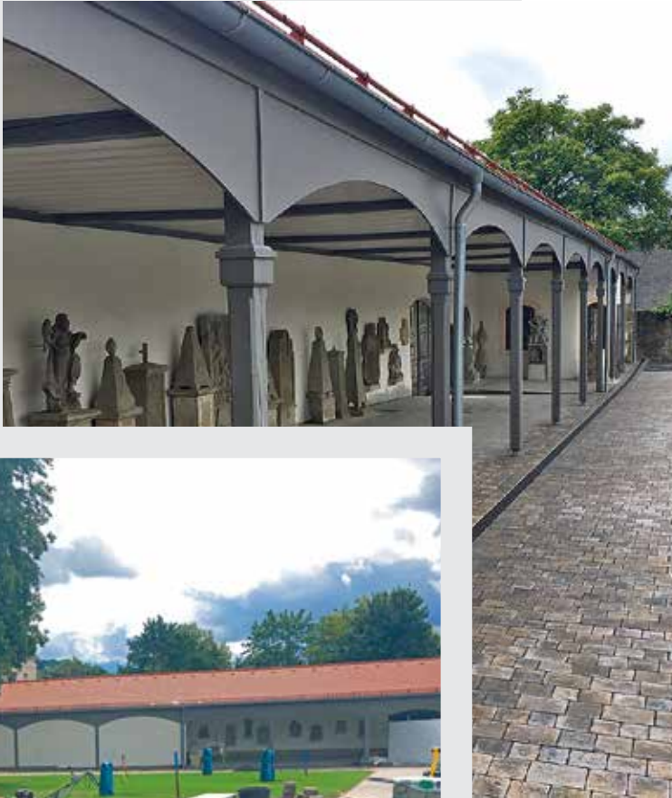
Eingangshalle am Hohntor
