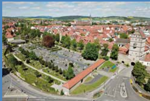
Sanierung des Altstadtfriedhofes
