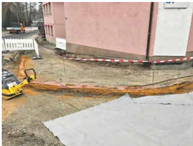
Kabelarbeiten Leutershauser Straße
