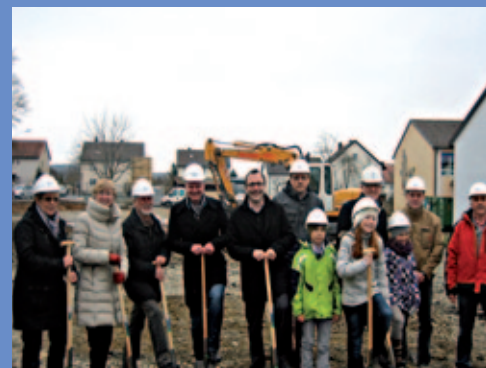
Erster Spatenstich Grund- schule Brendlorenzen
