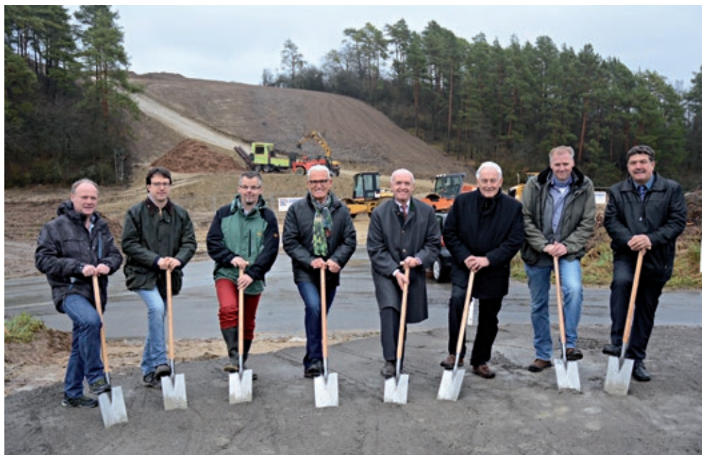
Gaben gemeinsam den Startschuss für den Neubau der Kreisstraße NES 20 (von links): Detlef Manger (Landratsamt Tiefbaubehörde), Dr. Christoph Schetter (Firma Kammerdiener), Ulrich Dolze (Planungsbüro Zehe), Bad Neustadts Bürgermeister Bruno Altrichter, Landrat Thomas Habermann, Bauunternehmer Armin Stolz (Bühl), Jürgen Beck (Staatliches Bauamt Schweinfurt) und Bürgermeister Michael Pöhnlein aus Rödelmaier. Foto: Stefan Kritzer
